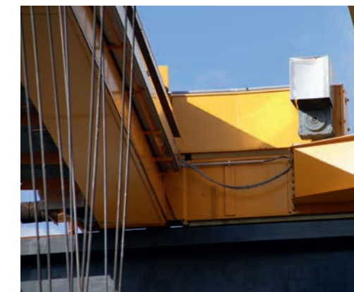
Kranbrücken in geschwenkter Stellung Crane girders in swivelled position
